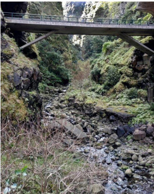
Abb. 3: Blick in das Ribeira do Inferno in Südrichtung, oben die Brücke der neuen Schnellstraße VR 2.
